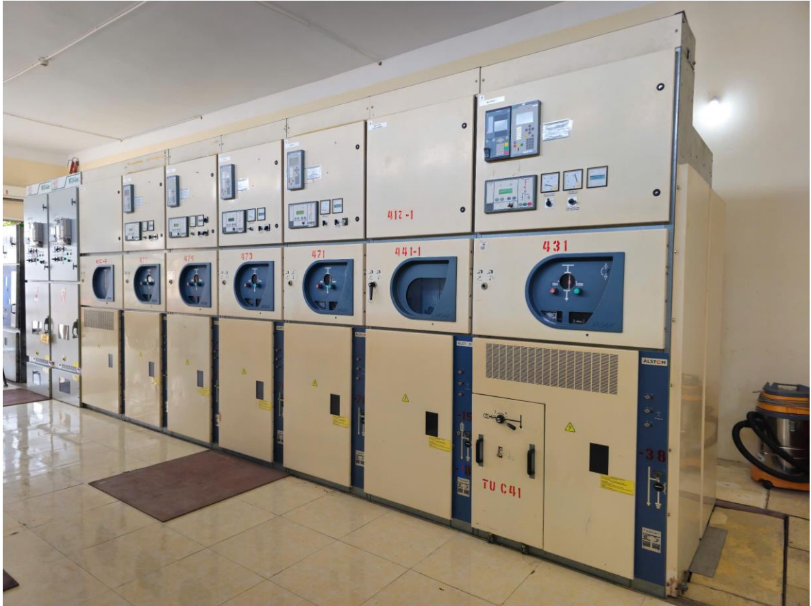
Hình ảnh dãy tủ hợp bộ 22kV – C41 trạm 110kV TP Thanh Hóa
