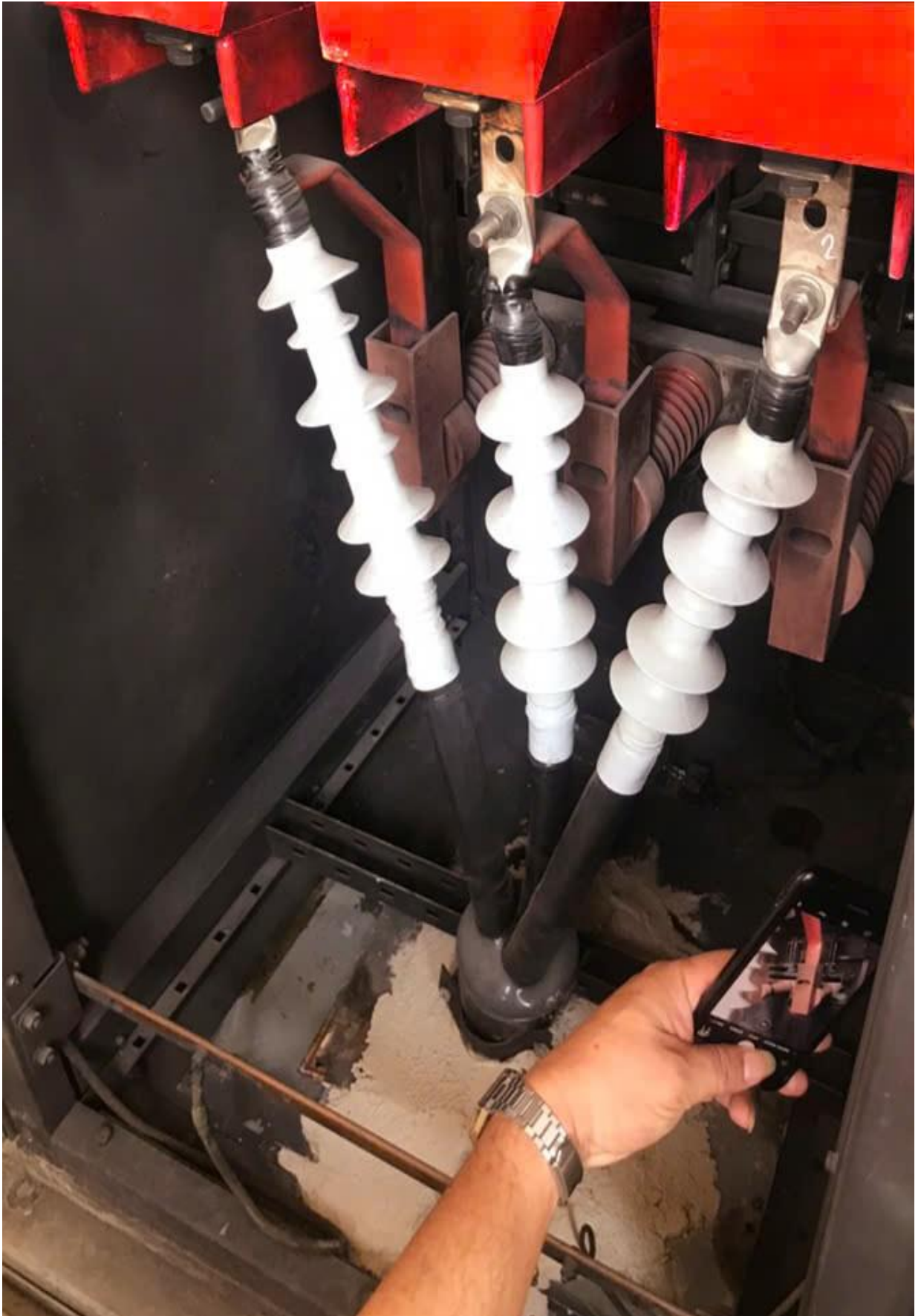
Hình ảnh ngăn đầu cáp tủ hợp bộ 473 sau khi vệ sinh thành tủ, vệ sinh và sơn 3M cách điện TI473 và thay đầu cáp 473 mới cho ngăn lộ 473
